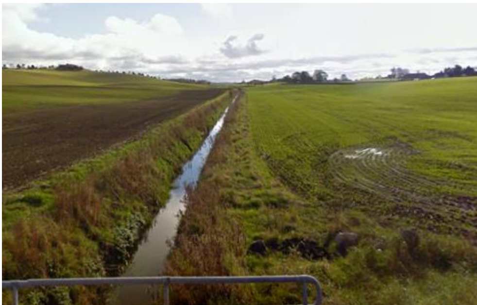
Figur 6. Tranemose å ved Kelleklintevej. Dybt nedstik og kanalisering.
