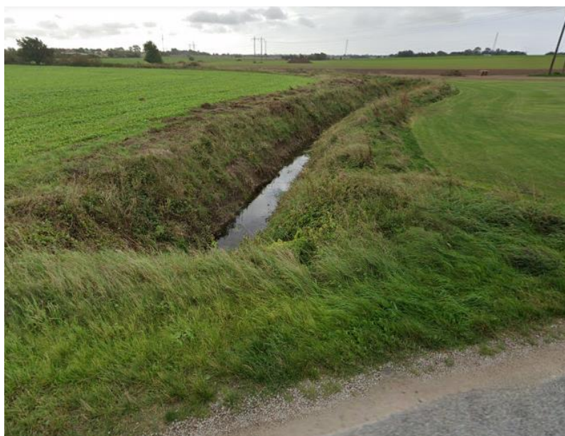
Figur 4. Duemoserenden viser meget dybt nedstik og kanalisering.
